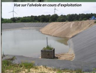
Vue sur l'alvéole en cours d'exploitation
